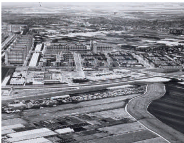
Luchtfoto gezien vanuit de Lutkemeerpolder eind jaren '60
